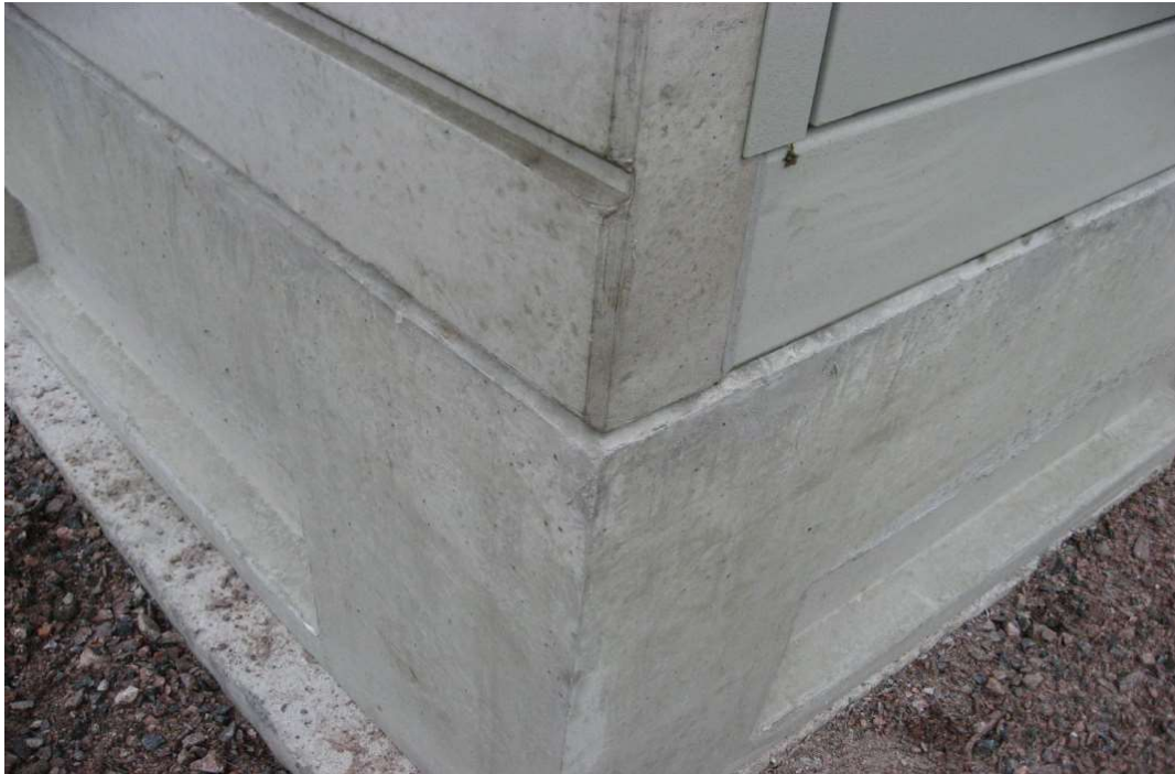
Kuva 8 Kaapelikellari ja runko kohdakkain
