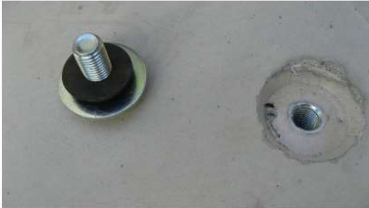
Kuva 6 Vedonpoistoruuvi auki
