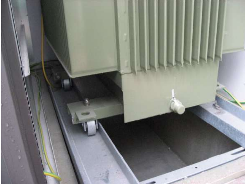
Kuva 11 Öljyaukalo ja muuntajan asennus
