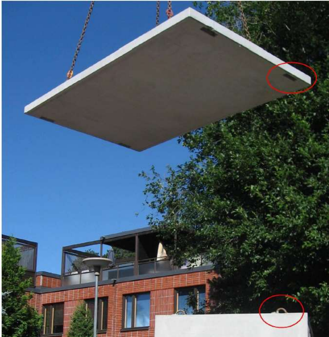
Kuva 12 Muuntamon katon asentaminen
