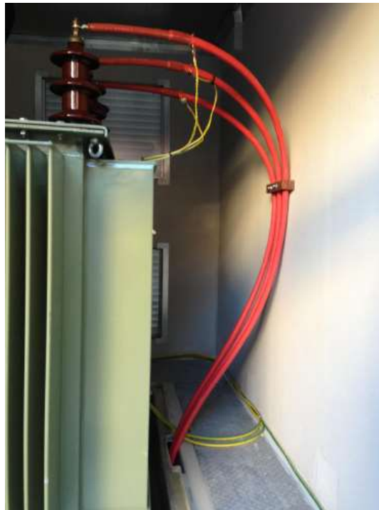
Kuva 8: KJ-kaapeli tuenta (esimerkki)
